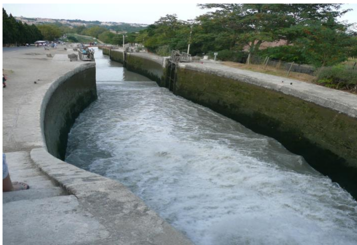
Béziers : Écluse de Fonsérane
