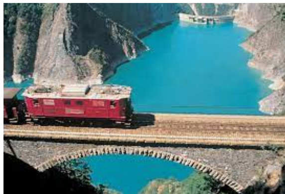
Barrage de Monteynard
