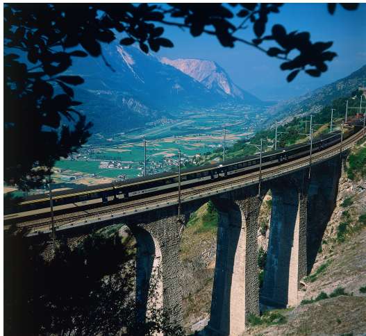
La rampe Sud du Lötschberg
